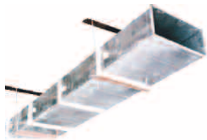
3.11 Réseaux de distribution d'air
