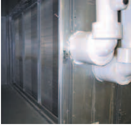
3.7 Serpentin de chauffage à eau chaude
