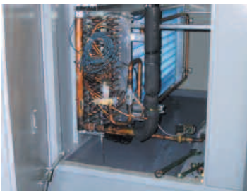
1.6 Serpentin de refroidissement à expansion directe
