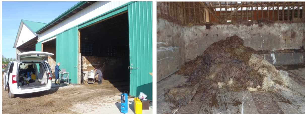
Figure 1 : Cellule de compostage du fumier (à gauche) et caniveaux d'aération (à droite) à la ferme de bovins laitiers (site LP).
