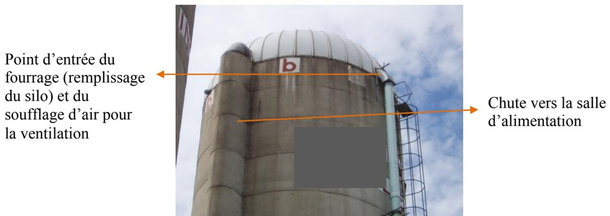
**Figure 2 : Silo à fourrage avec point d'entrée et chute vers la salle d'alimentation.**
