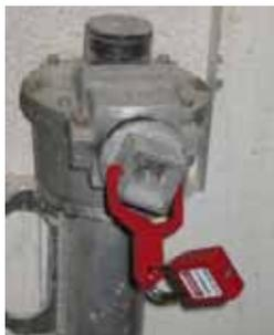
**Figure 22 – Accessoire de cadenassage développé pour les vannes à actionneur carré**
