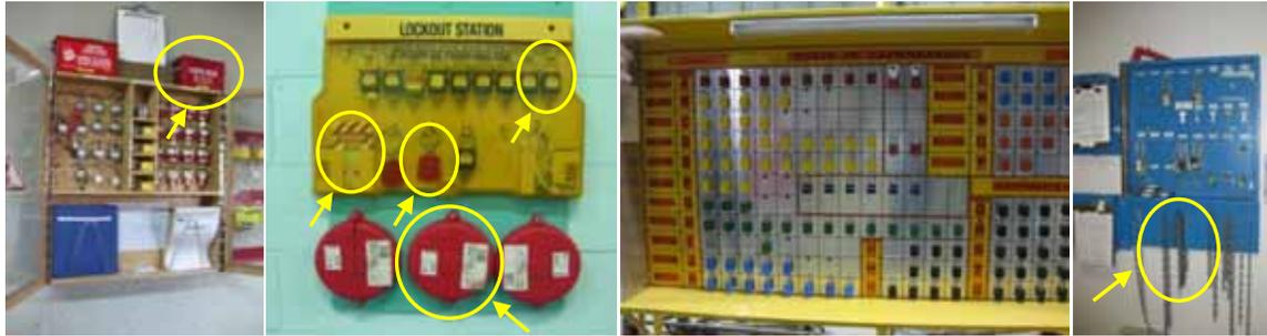
**Figure 6 – Postes de cadenassage observés dans différentes municipalités avec de gauche à droite (repères ajoutés) une boîte de cadenassage, des étiquettes, des morailons, des cadenas, un couvre-valve, des chaînes**
