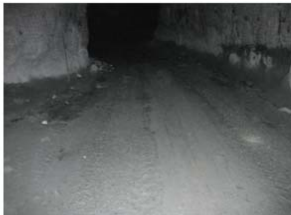
État de la rampe entre le point de chargement et de déchargement de rugosité inférieure à la moyenne. Très bonne condition.
