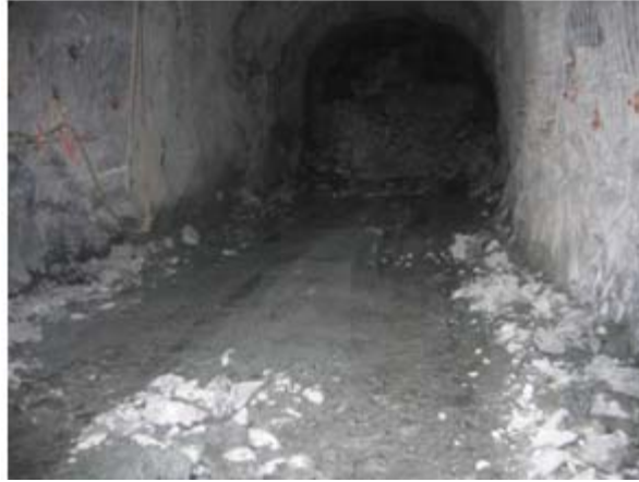
Rugosité du plancher au point de soutirage légèrement plus raboteux que la moyenne. Minerai assez fin (pas de gros blocs).
