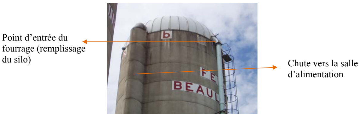
Figure 4-1: Silo #1 en béton
