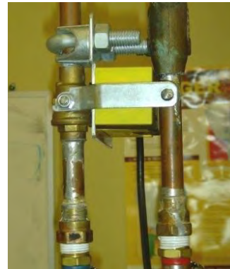
Figure 24: Installation du capteur de proximité (jaune)
