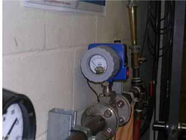
**Figure 4: Débitmètre utilisé lors des essais**
