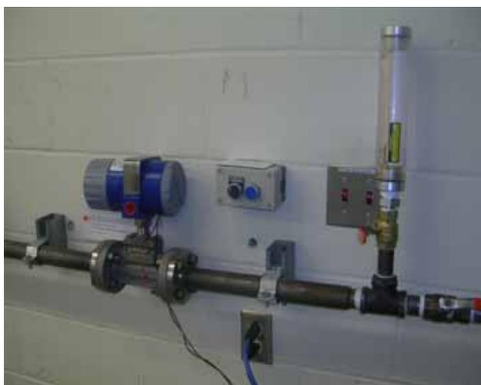
**Figure 30 : Rotamètre en série avec le Vortex**
