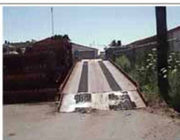
Pentes inégales et abruptes générant des manœuvres compliquées pour les caristes
