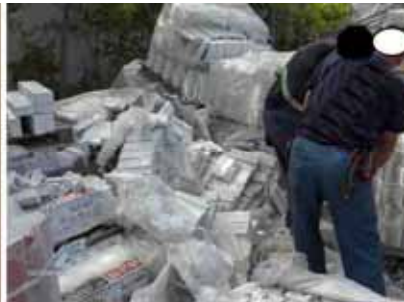
Figure 14 : Quatre palettes de briques renversées
