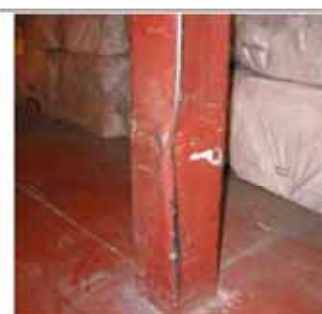
Poteaux et éléments de structure accrochés
