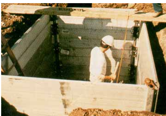
(a) Caisson « Gigant alu de Ischebeck » (Source : Ischebeck, 2006)
