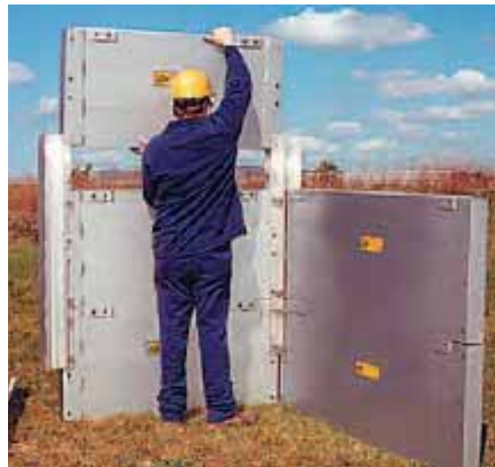
(b) Assemblage du caisson
