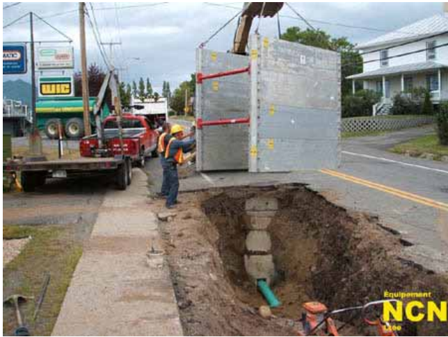
(a) Assemblage du caisson (Source : Équipement NCN Ltée, 2006)
