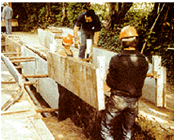
(a) Assemblage du caisson
