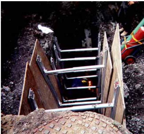
(a) Vue à l'intérieure de l'étançonnement avec vérins hydrauliques «vertical shore»
