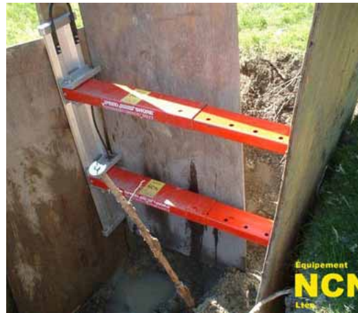
(b) Vue en élévation de l'étançonnement avec vérins hydrauliques «vertical shore»
