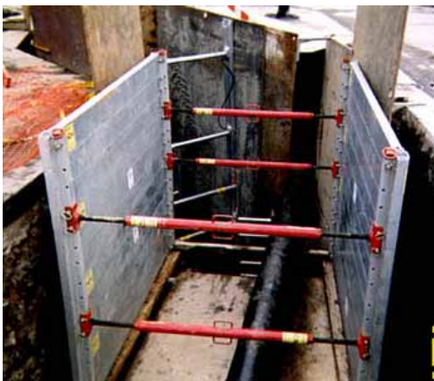
(a) Vue des étrésillons (Source : Équipement NCN Ltée, 2006)
