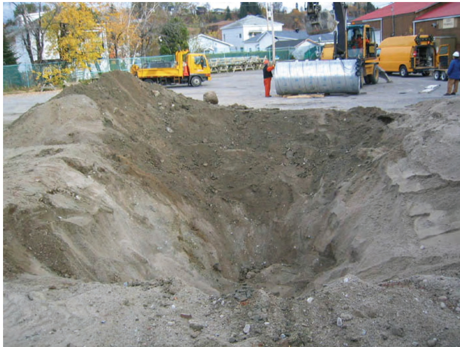
Figure 3.7 Excavation de la tranchée – 24 octobre 2005.
