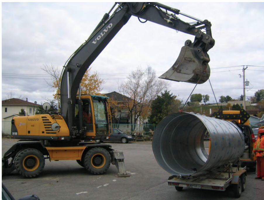
Figure 3.3 Manutention à l'aide d'une pelle rétro-excavatrice.
