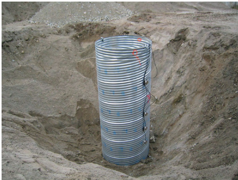
Figure 3.9 Installation du TTAOG-1500 dans l'excavation – 24 octobre 2005.
