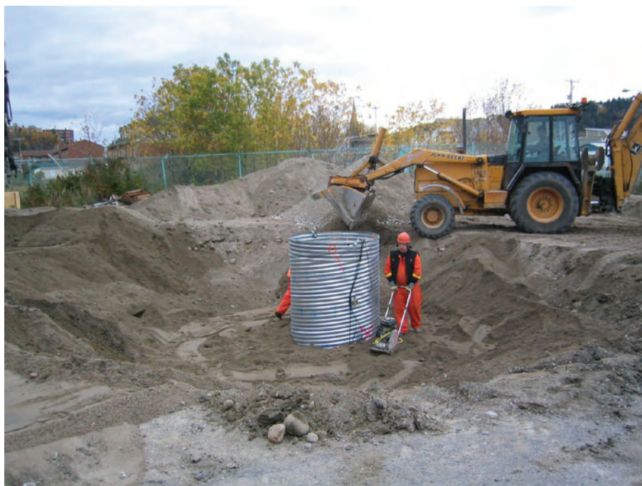
Figure 3.9 Installation du TTAOG-1500 dans l'excavation – 24 octobre 2005.
