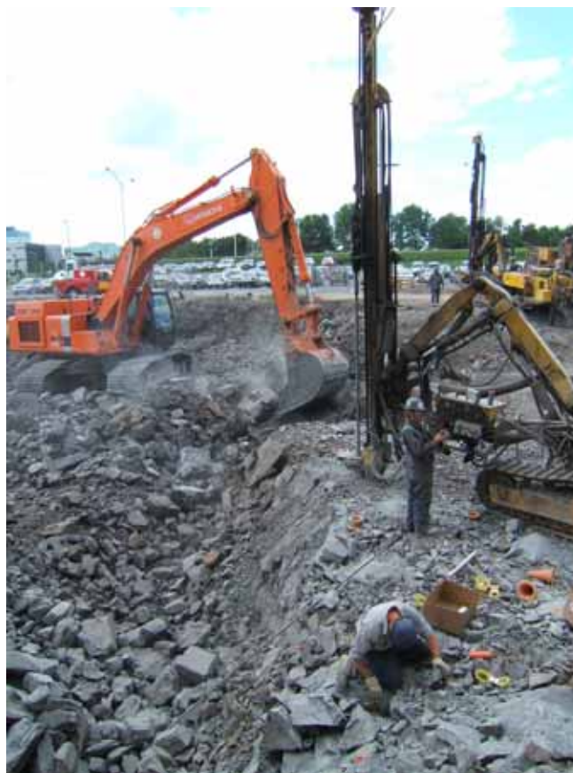
Figure 23 : Localisation typique des travailleurs lors des opérations de chantier (Après le sautage 8B)
