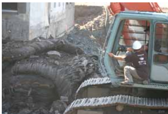
Figure 26 : Mesure des concentrations en CO lors des opérations d'excavation par la pelle
