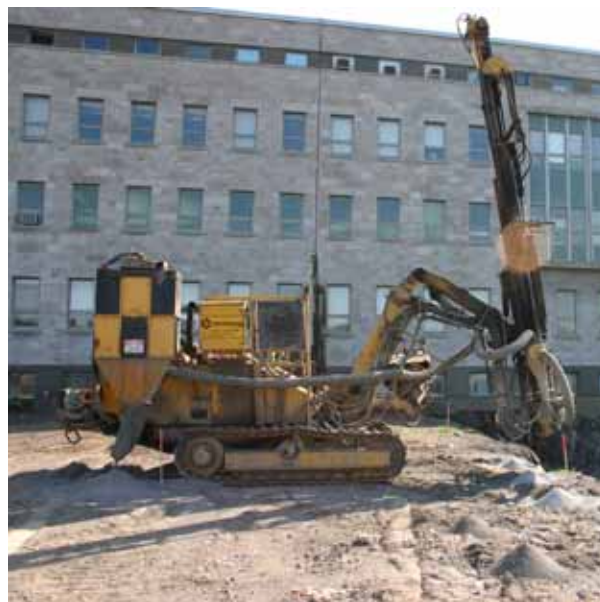
Figure 13 : Foreuse roto percussion avec système d'injection d'air utilisée lors des travaux en chantier
