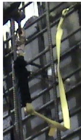
Longe avec absorbeur d'énergie de la compagnie «DBI Sala, modèle EZ-Stop II – 1220048C, 1,52 m de long
