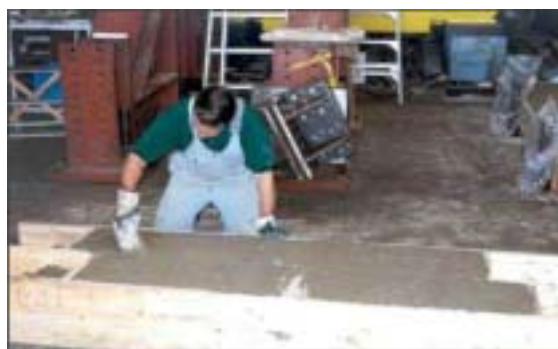
Figure 21 : Fabrication des dalles supérieures
