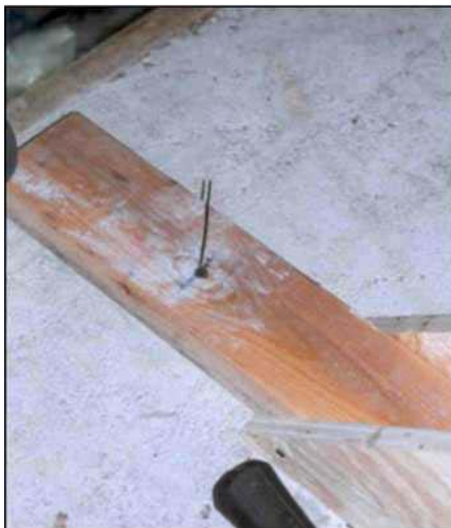
Figure 23 : Assemblage des montants des garde-corps de type 1 à la dalle inférieure
