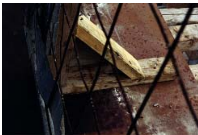
Figure 12 : Jambe en 2x4 pour solidifier le montant
