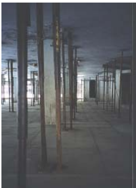
Figure 13 : États métalliques utilisés comme fausse charpente de coffrage
