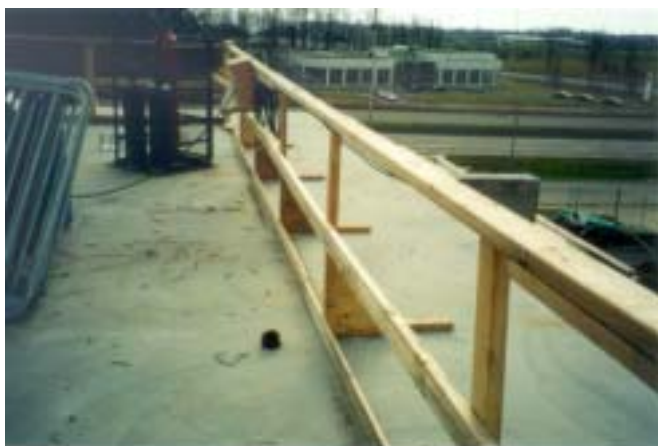
Figure 9 : Garde-corps en bois près du vide sur une dalle de béton
