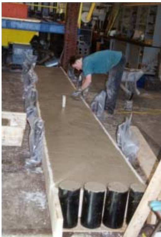
Figure 20 : Fabrication de la dalle inférieure
