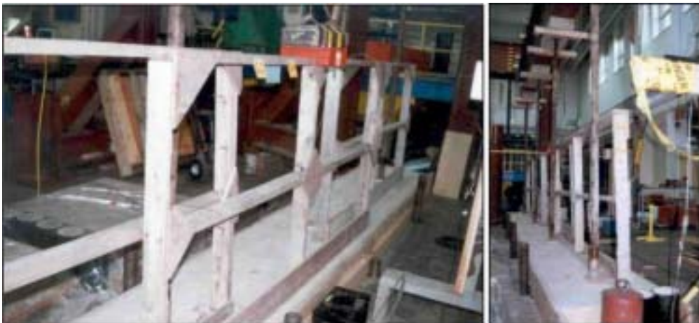
Figure 49 : Chevauchement des sections de garde-corps (essai 6-6)
