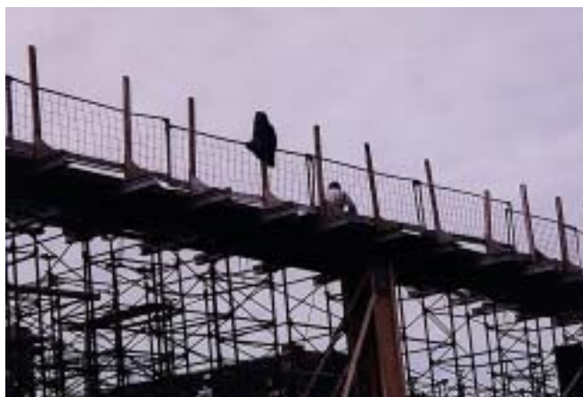
Figure 10 : Garde-corps en bordure du vide sur la fausse charpente de coffrage
