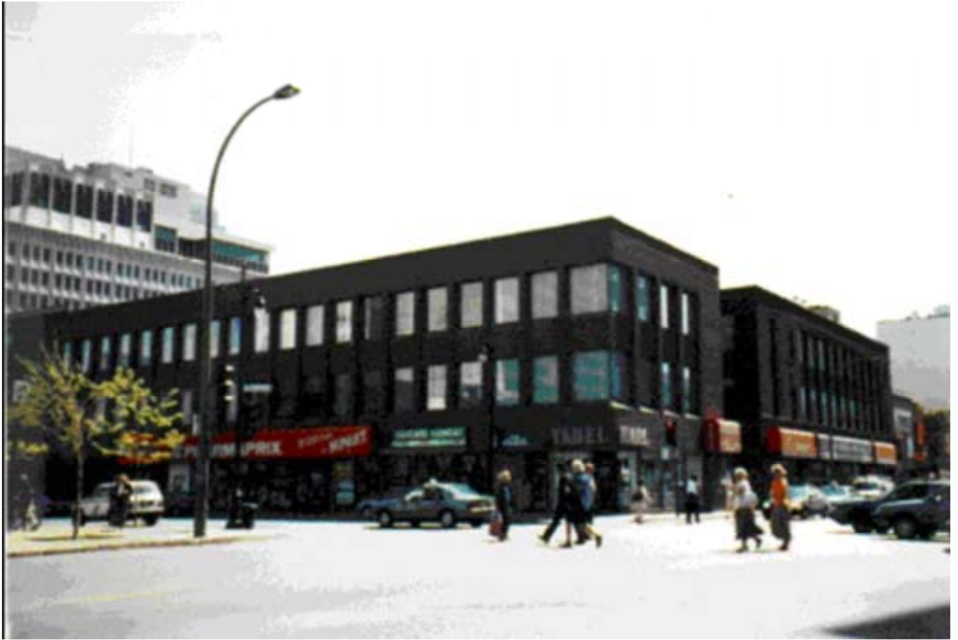
Figure 4.1 Bâtiment BE, Centre des études sur le bâtiment, Université Concordia, Montréal, vu de l'ouest.
