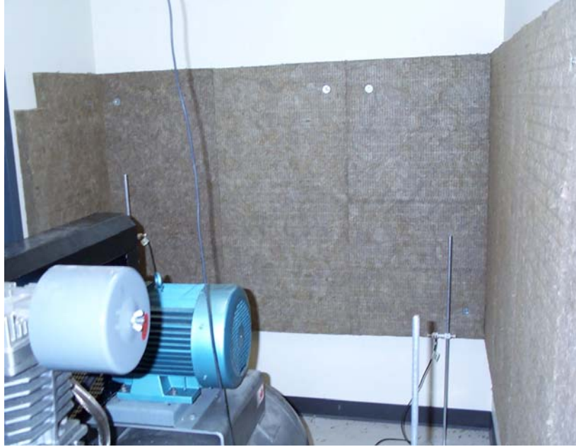
Figure 6 – Autre vue du traitement partiel des murs du local avec de la laine minérale homogène
