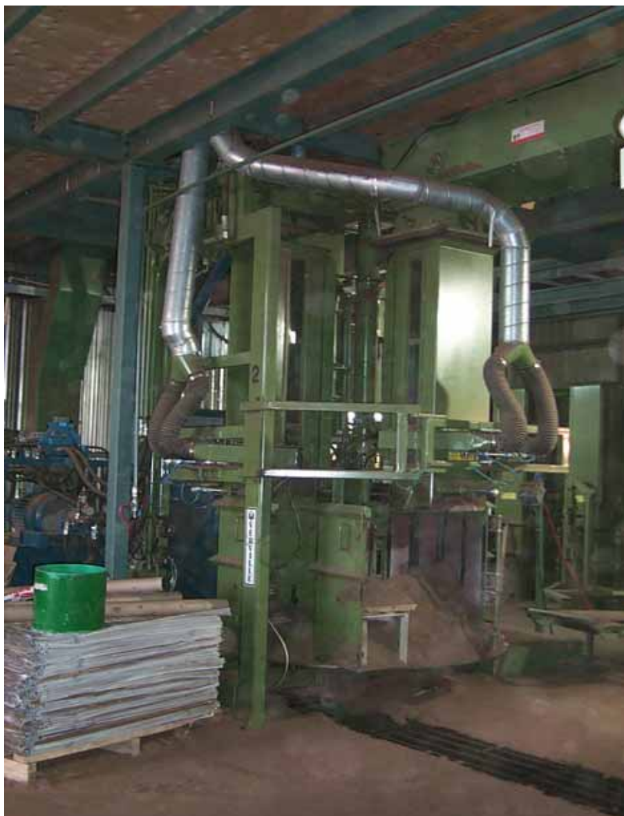
Photo 12 : Presse ensacheuse (non en opération).
