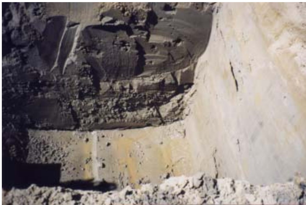
Figure 3.23 - Essai 2.3.A : Excavation de la tranchée A (avec une paroi inclinée à 45 degrés) Ville de Victoriaville
