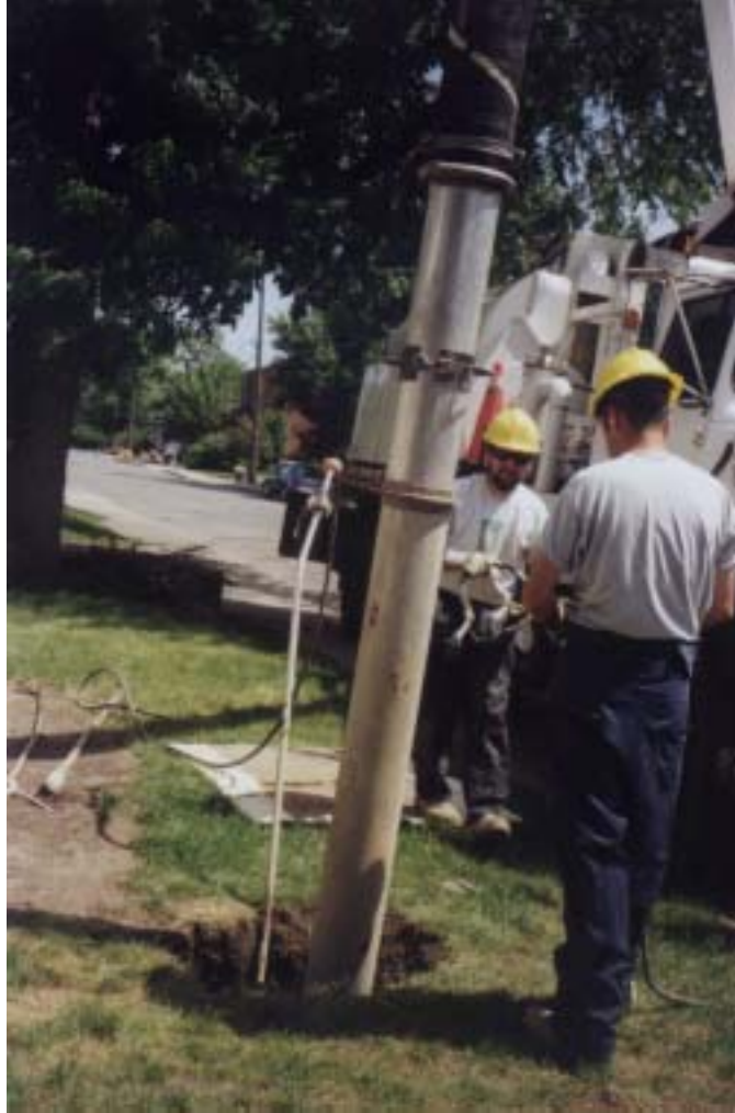
Figure 2.3 (b) - Équipement utilisé pour l'hydrocuretage (forage par aspiration ou vacuum)
