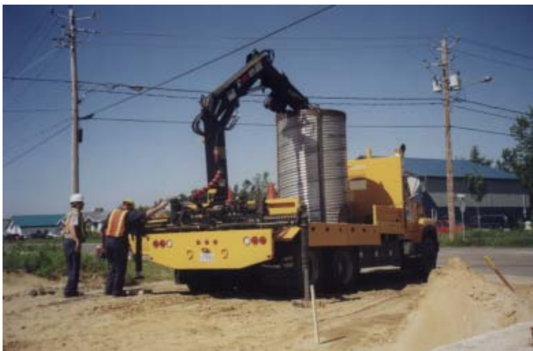
Figure 3.24 - Essai 2.3.A : Transport du TTAOG-60 dans la tranchée A Ville de Victoriaville - 21 juin 2001
