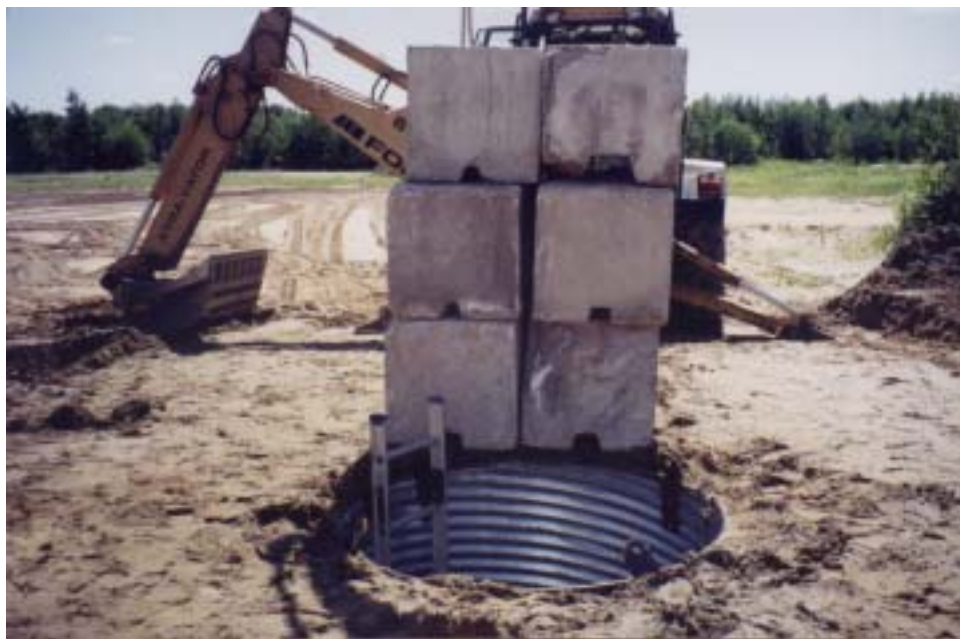
Figure 3.27 - Essai 2.3.B : Début du remblayage autour du TTAOG-60 Ville de Victoriaville
