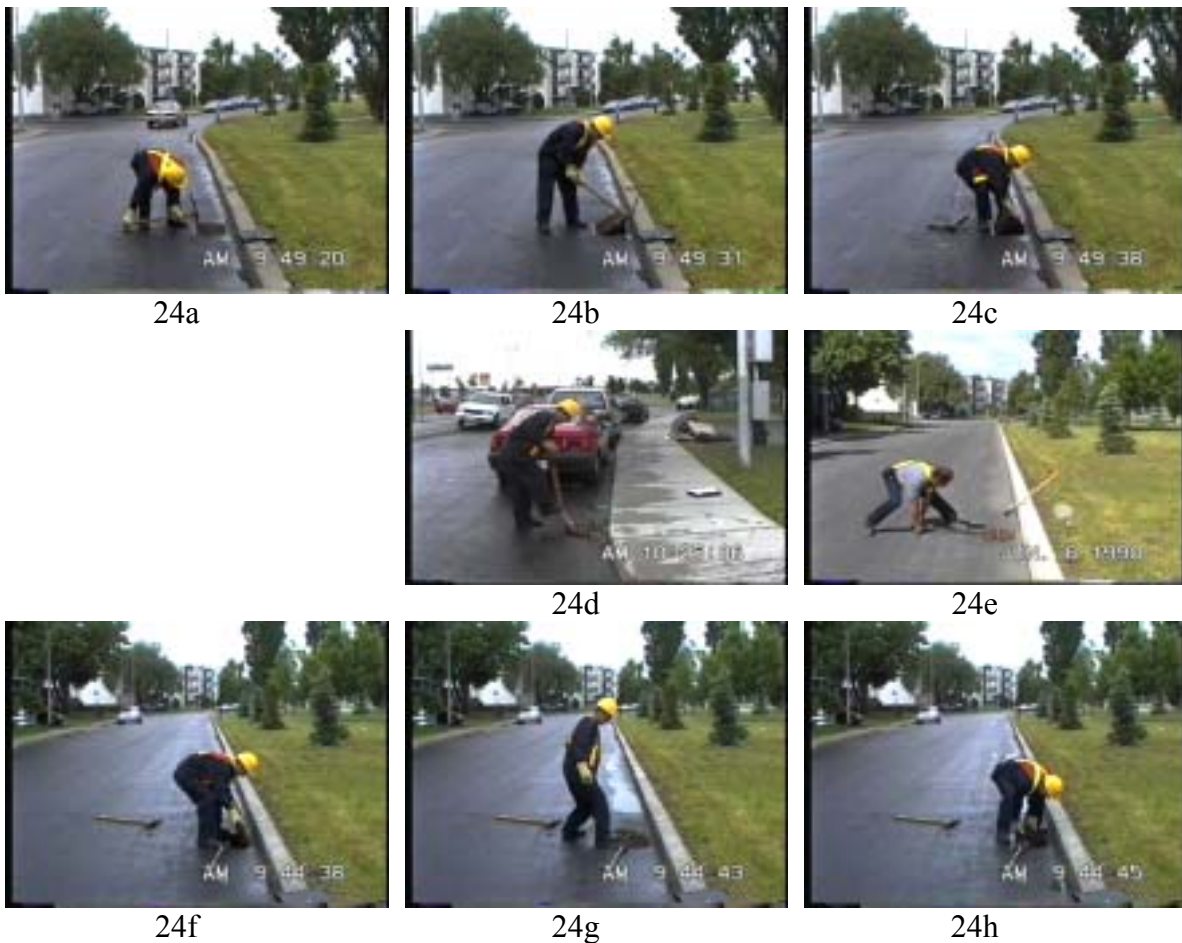
Figure 24: Postures adoptées pour ouvrir (a, b, c, d, e), puis fermer des grilles munies d'un verrou à ressorts (f, g, h)
