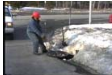
Étape 5: Dégagement de l'ouverture du puits.
