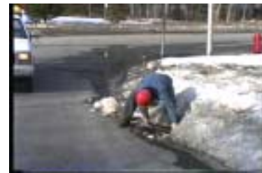
Étape 3: Insertion de l'outil dans le couvercle (ici un crochet).
