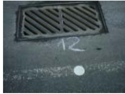
Figure 6: Grille rectangulaire à rainures obliques
