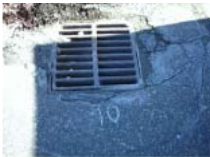
Figure 3: Grille carrée à rainures
