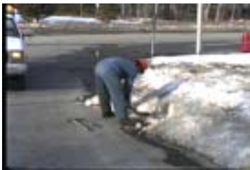
Étape 1: Dégagement du couvercle (ici avec une pelle).
