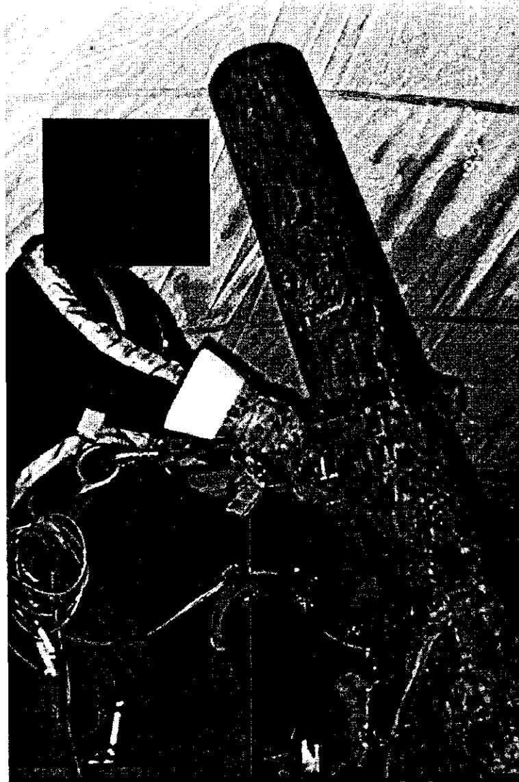
Figure 13 Monteur utilisant une courroie de positionnement munie d'un système d'arrêt de chute
