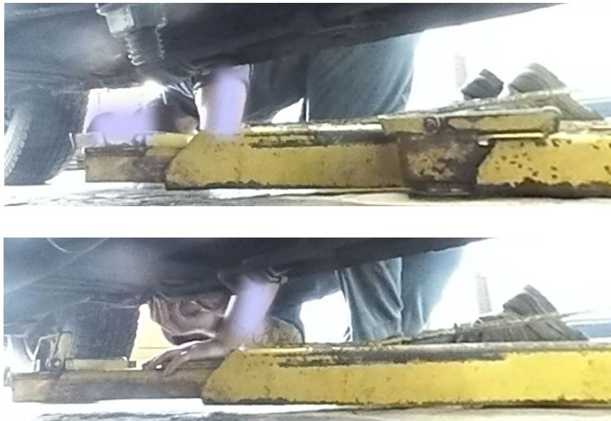
Figure 24. Évaluation visuelle et tactile des points de levage d'un véhicule rouillé.
