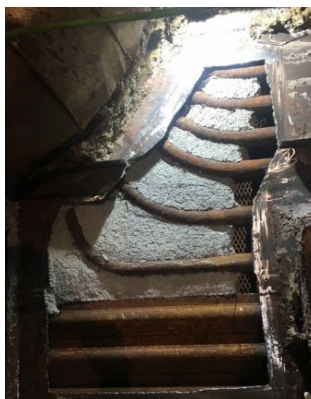
Figure 13. Ouverture dans la structure de la chaudière, sans être un accès, pour permettre une inspection ou un nettoyage depuis l'extérieur (EC_ID : 18; solution n° 101).
