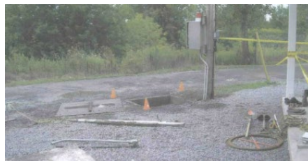
Figure 6. Entrée de la station de pompage (CNESST, 2005, EN-003536).
