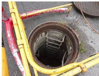
Figure 1. Puits d'accès dans le secteur municipal.
