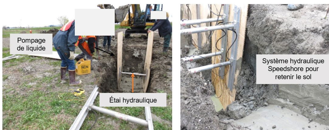
Figure 35. Installation des feuilles de contreplaqué et des étais hydrauliques dans la tranchée C.
