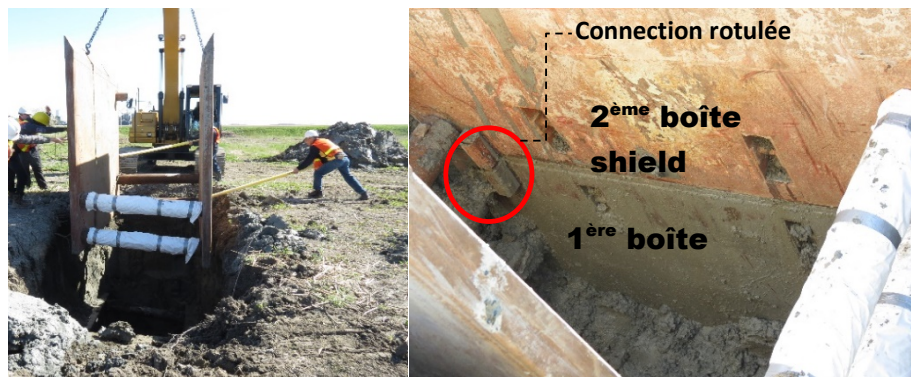
Figure 33. Mise en place des boîtes de tranchée dans la tranchée B.
