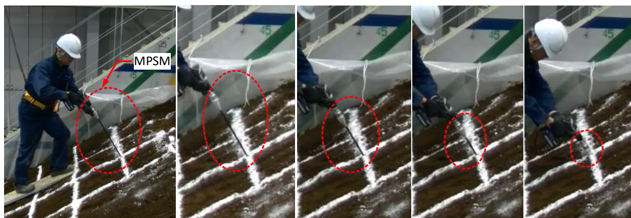
Figure 3. Installation du MPSM à l'aide d'une perceuse portative en moins de 10 secondes.
