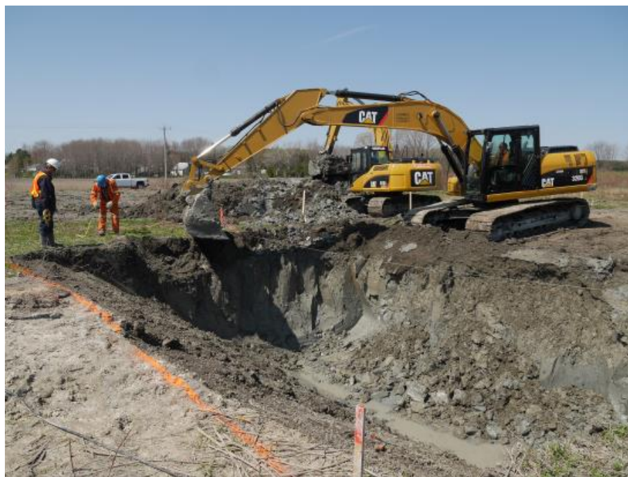
Figure 20. Excavation de la tranchée A2 avec des excavatrices Caterpillar 315 et 320.
