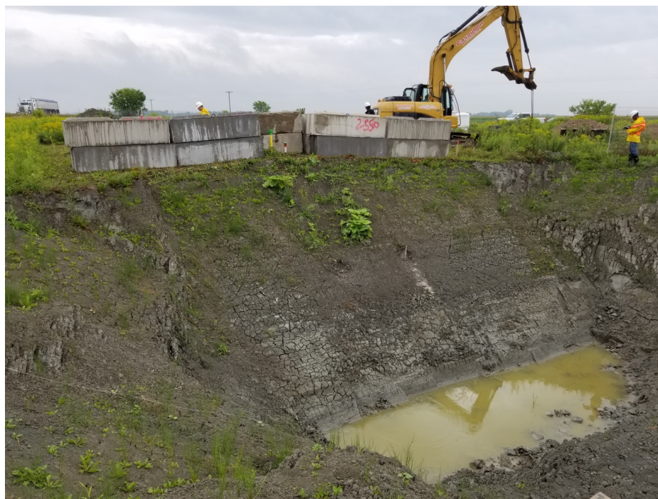
Figure 23. Chargement de la tranchée A2 avec des blocs en béton.
