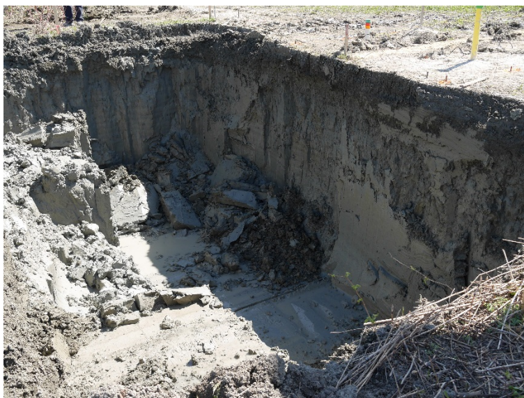
Figure 28. Rupture causée par écaillage et venue d'eau durant l'excavation de la tranchée A1 (étape 3).
