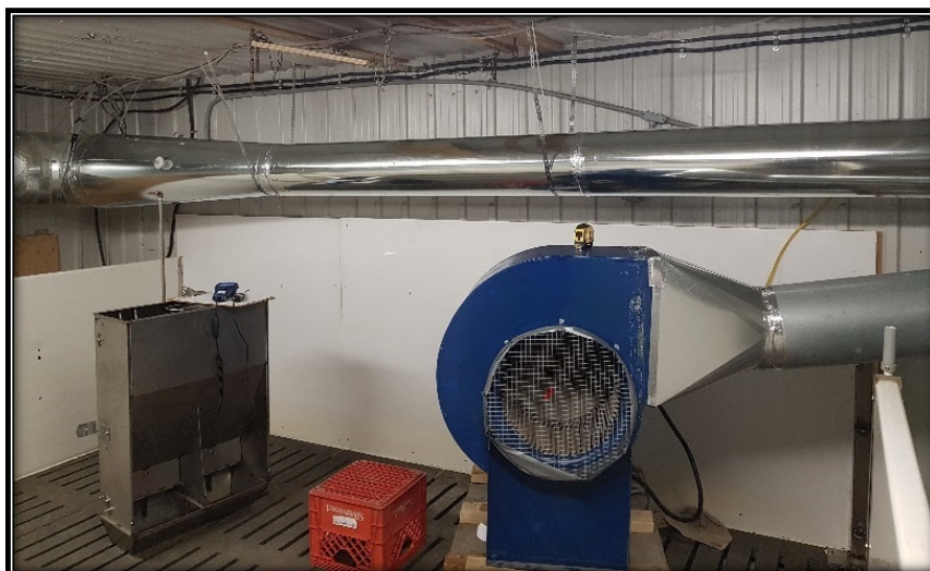
Figure 9. Test de calibration du ventilateur de sortie d'une des salles.
