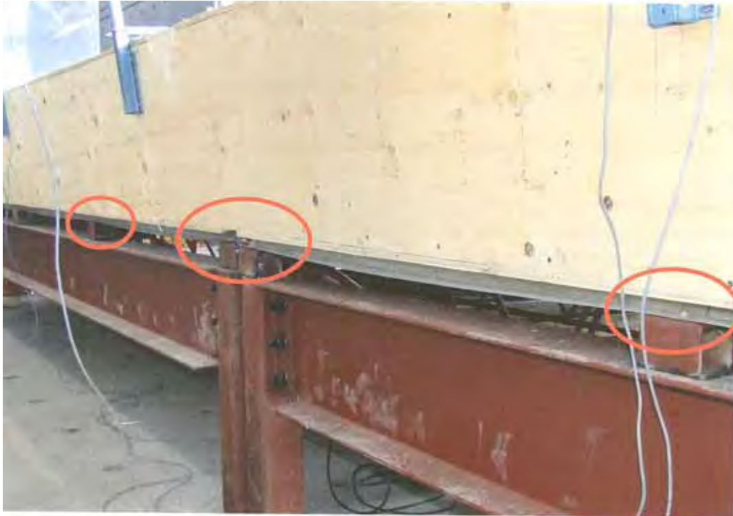
Figure F-60 – Écrasement du pontage métallique au niveau des appuis pour la configuration où le parapet est perpendiculaire aux poutrelles (série INSR, parapet flexible).
