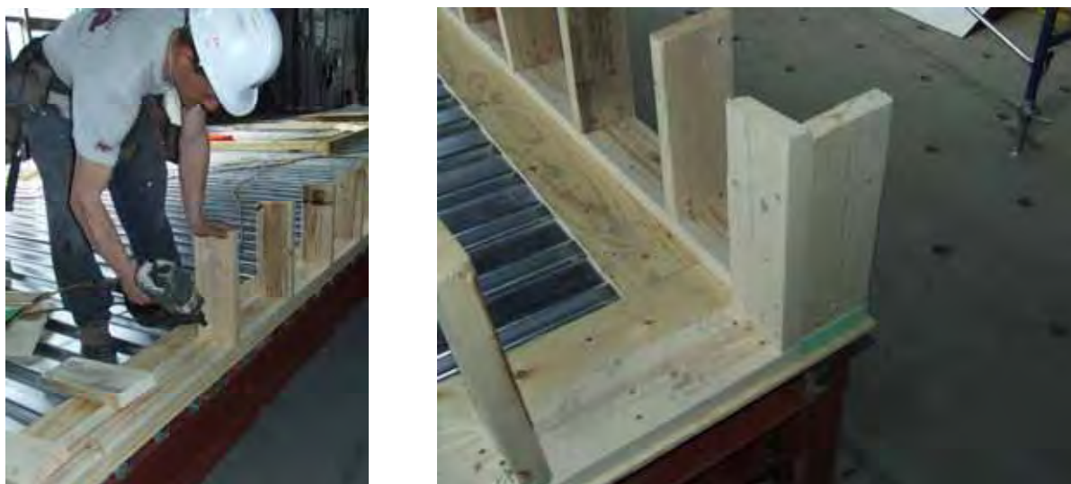
Figure F-27 - Installation du madrier de base.
