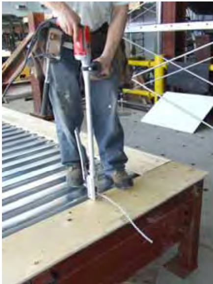
Figure F-26 - Installation du contreplaqué de base.
