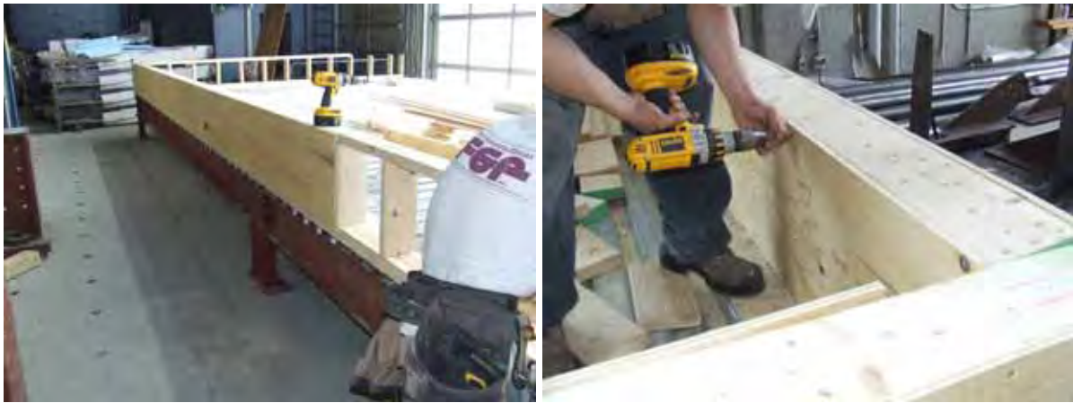
Figure F-30 - Installation des contreplaqués de surface.
