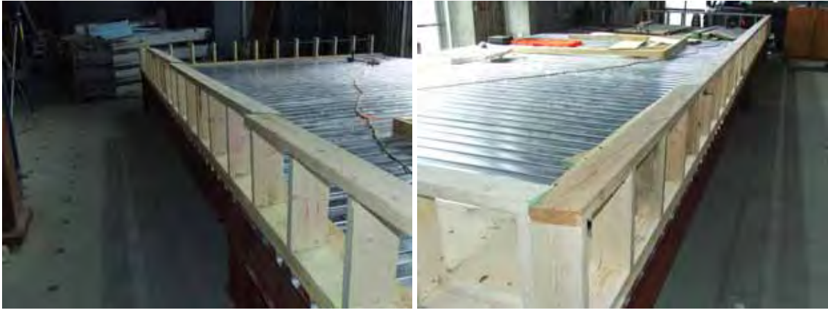
Figure F-29 - Installation des madriers de tête.
