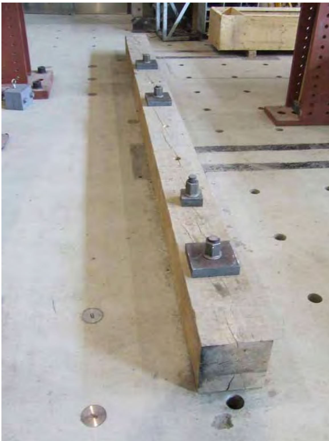
Figure F-4 - Bille de bois utilisée pour la fixation des garde-corps.
