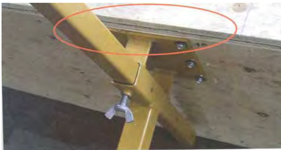
Figure F-133 – Décollement du contreplaqué lors de l'essai GC-MAL-INSR-1m-03SB sous une charge horizontale de 620 N.
