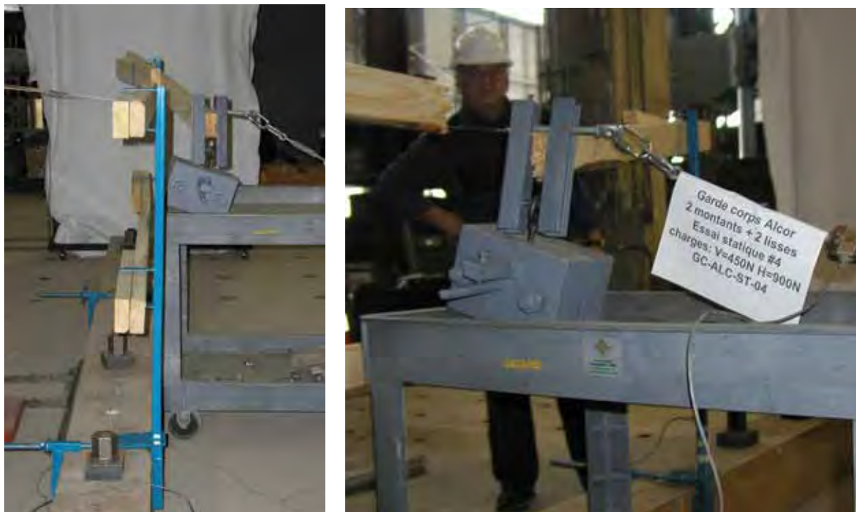
Figure F-45 – Essai de résistance statique Alcor GC-ALC-ST-04 : Rupture de la lisse supérieure.
