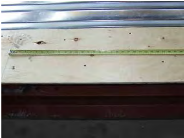
Figure F-26 - Installation du contreplaqué de base.
