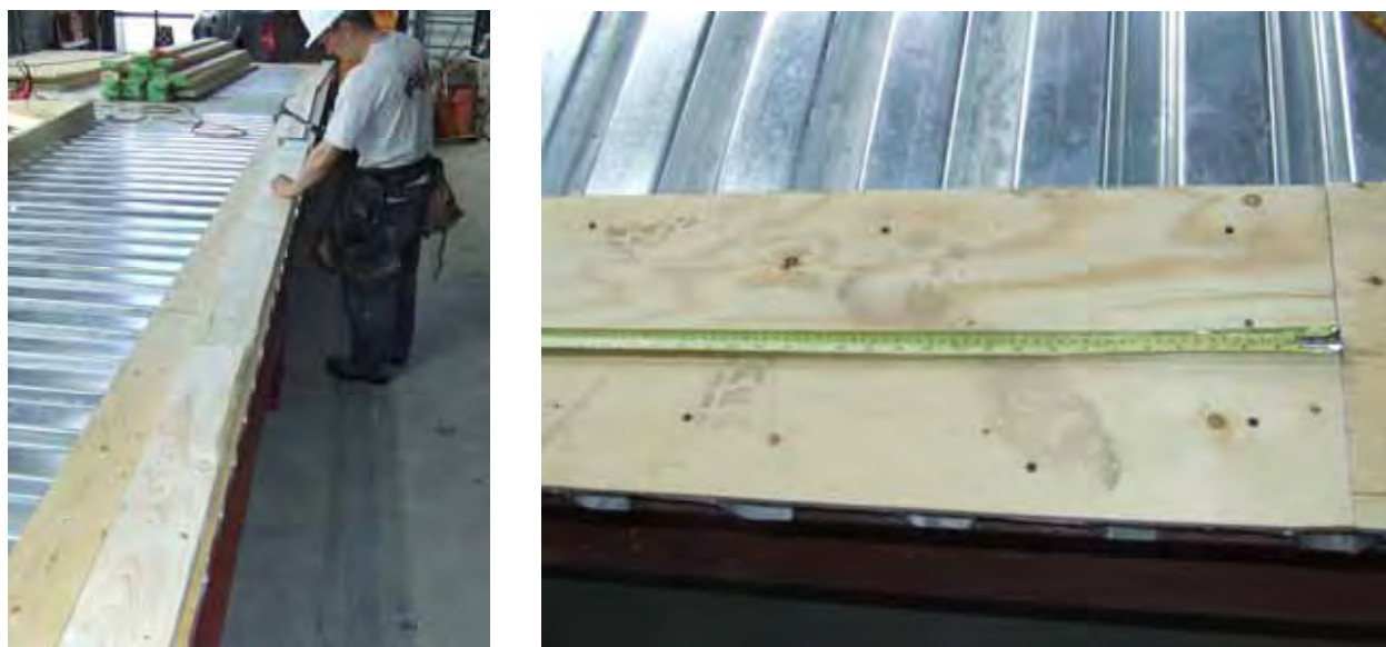
Figure F-27 - Installation du madrier de base.
