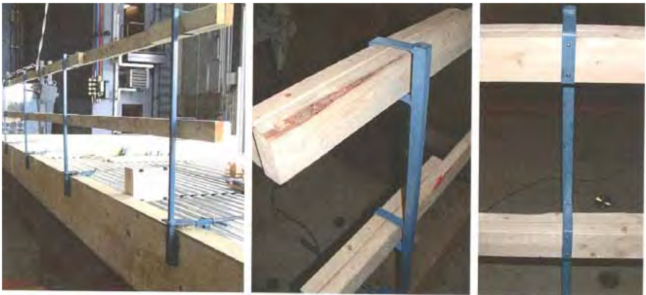
Figure F-6 – Détail des lisses du garde-corps Alcor.
