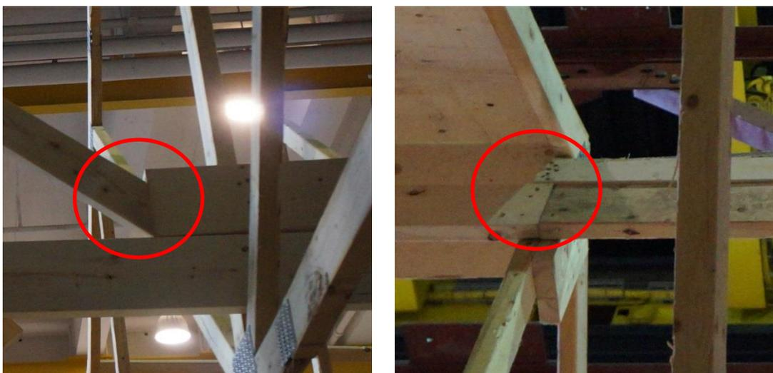
Figure 27 - Membrures mises bout à bout pour améliorer la transmission des efforts horizontaux.
