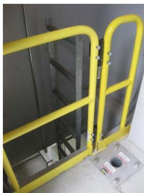
**Figure 7 - Socle pour potence, échelle et garde-corps intégrés de façon permanente**
