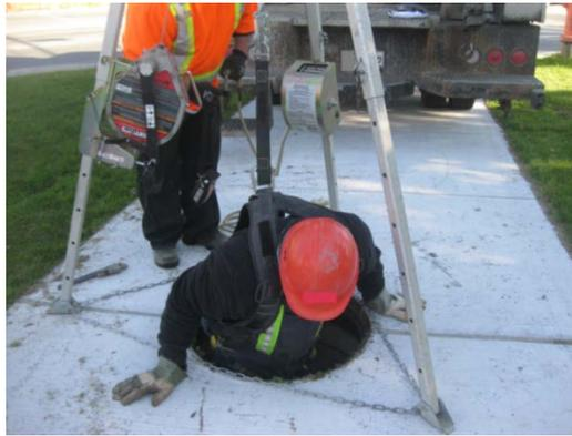
**Figure 6 - Trépied et treuils pour la protection contre les chutes et le sauvetage sans entrée;
