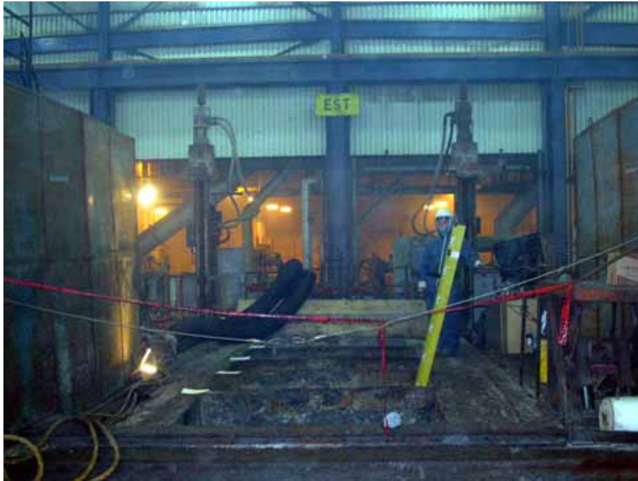
Figure 1 : Travaux de réfection d'un four
