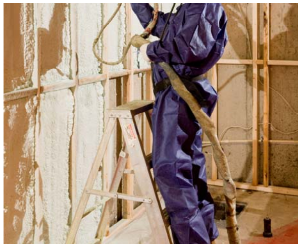
Figure 8 : Positionnement du travailleur sur un échelon de l'escabeau (Pierre Charbonneau, photographe)
