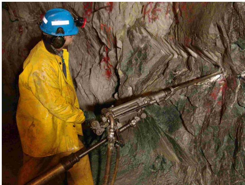
Figure 1. Foreuse à béquille en situation de forage
