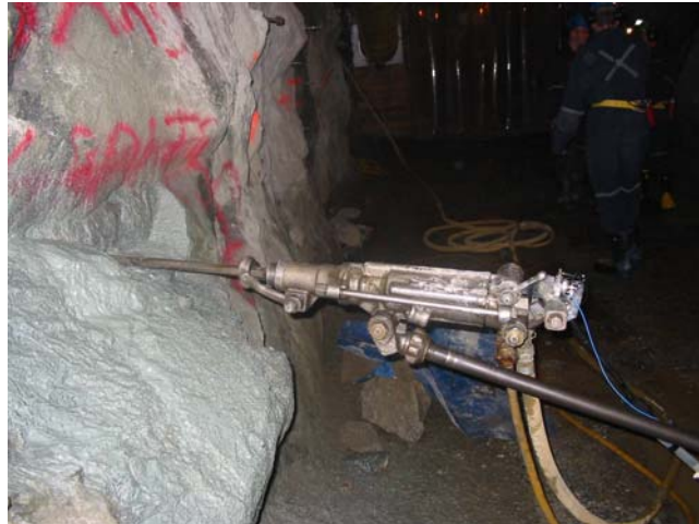
Figure 18. Foreuse à béquille en position de forage
