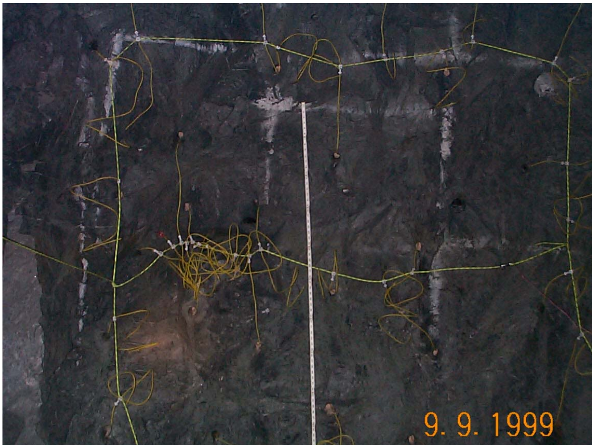
Figure 3.7b: Photographie montrant le patron de forage standard
