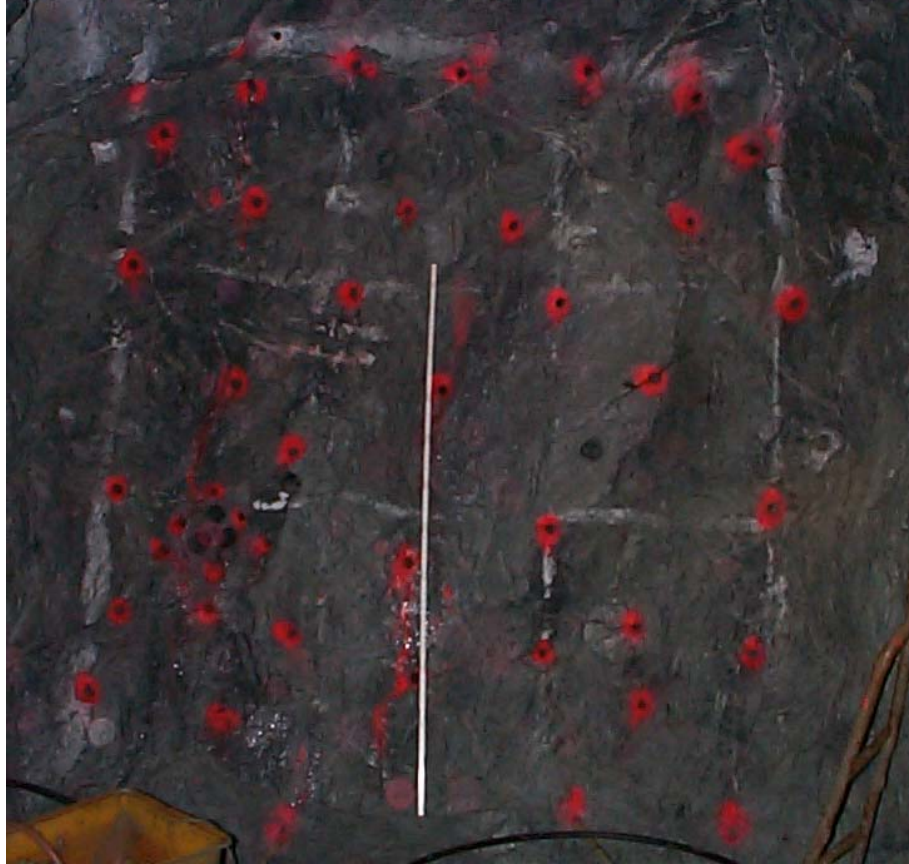
Figure 3.8b: Photographie montrant le patron de forage adouci
