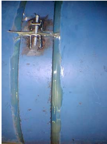
Figure 34. Photographie du traitement viscoélastique utilisé
