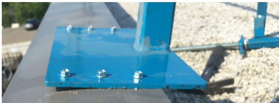
Figure 41. Garde-corps 1 testé sur le terrain, fixation sur la face horizontale du parapet avec 6 vis.
