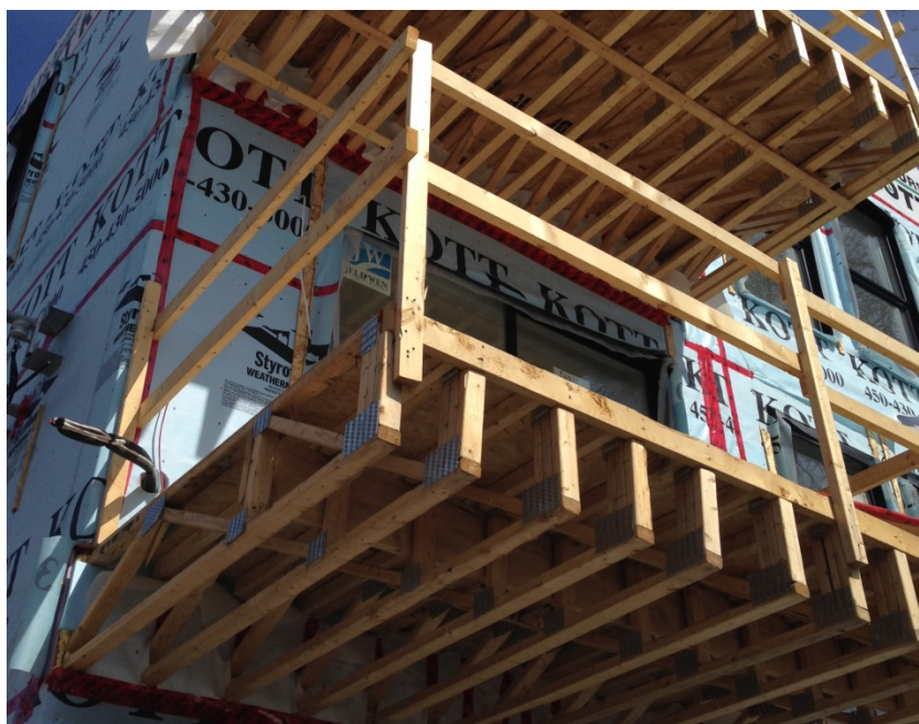
Figure 3. Garde-corps temporaire en bois installé sur des solives ajourées.
