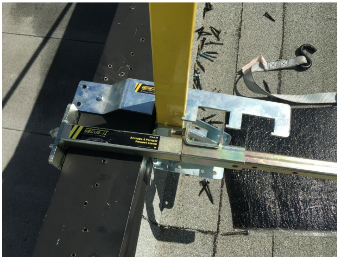
Figure 45. Garde-corps 3 installé sur le parapet 4.
