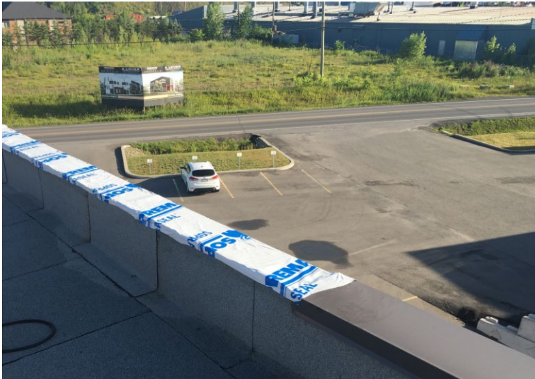
Figure 37. Parapet 3 après réparation avec membrane d'étanchéité.
