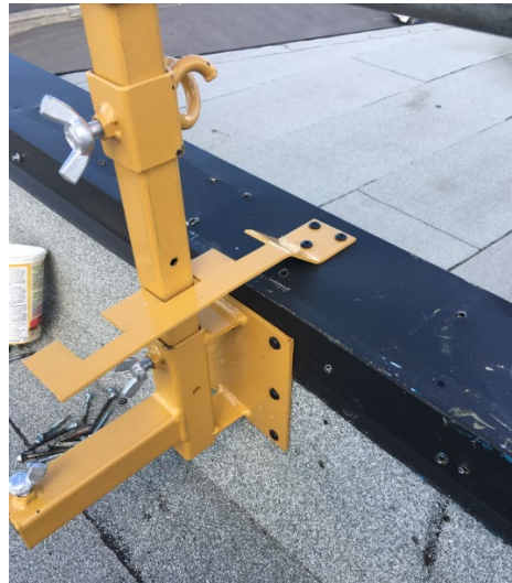
Figure 43. Garde-corps 2 avec stabilisateur de poteau de type plaque métallique.
