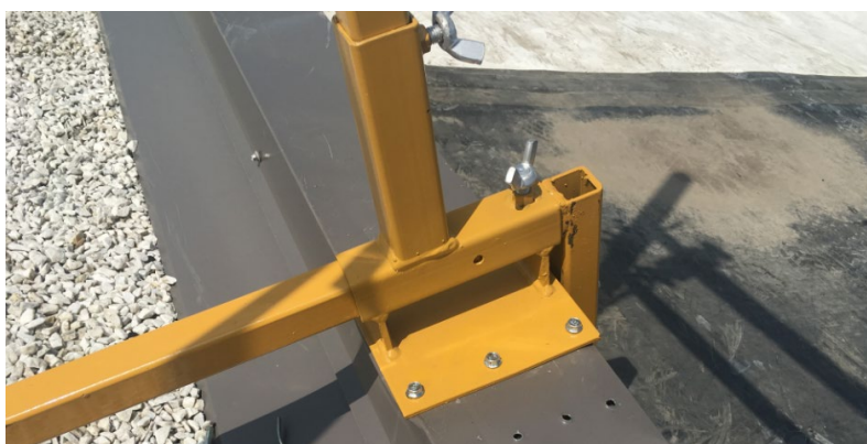
Figure 42. Garde-corps 2 avec stabilisateur de poteau en L.
