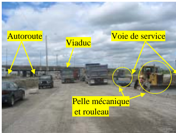
Figure 8 : Aperçu du chantier
