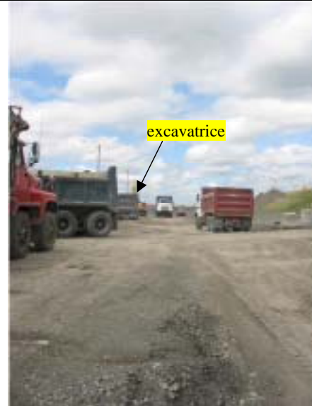
Figure 9 : Second aperçu du chantier
