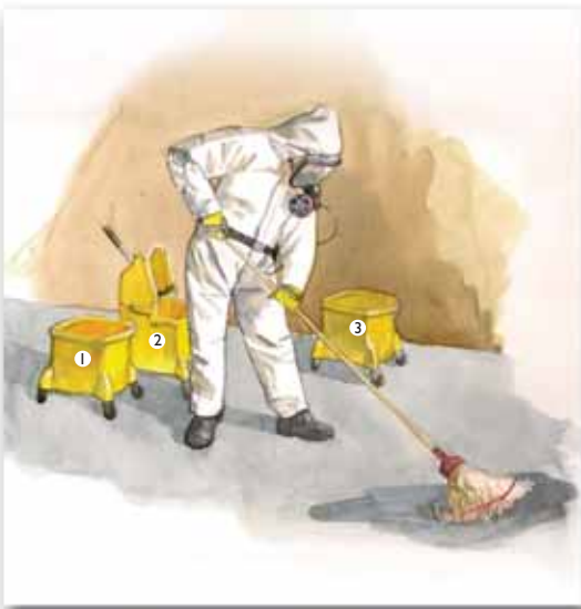
Figure 2 : Technique de nettoyage humide avec trois seaux
