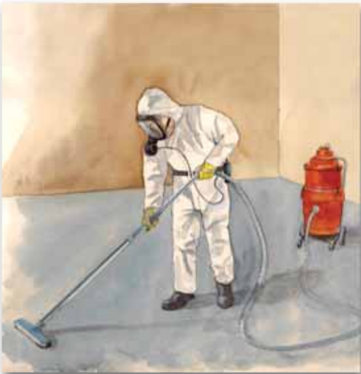
Figure 1 : Nettoyage par aspiration à l'aide d'un aspirateur muni d'un filtre HEPA
